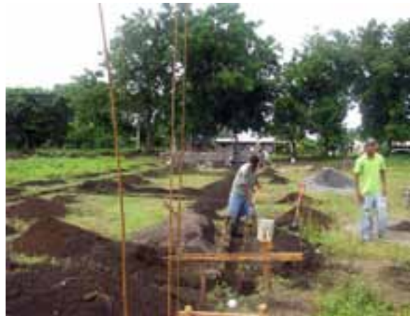
Endlich Baubeginn! Dies soll einmal eine Markthalle werden, in der ländliche Produkte direkt von den Produzenten angeboten werden können
