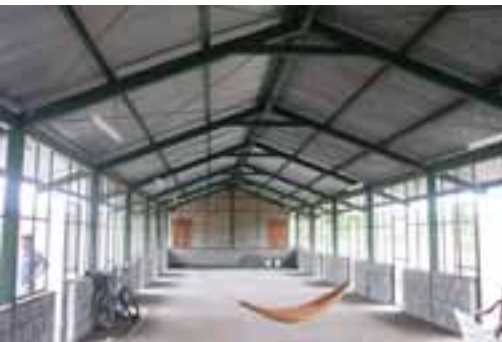
MELPAC: Hier ist die Markthalle fast fertig
