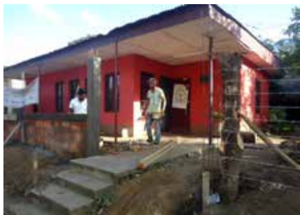
Baumaßnahmen am Zentrum von CECAMO
