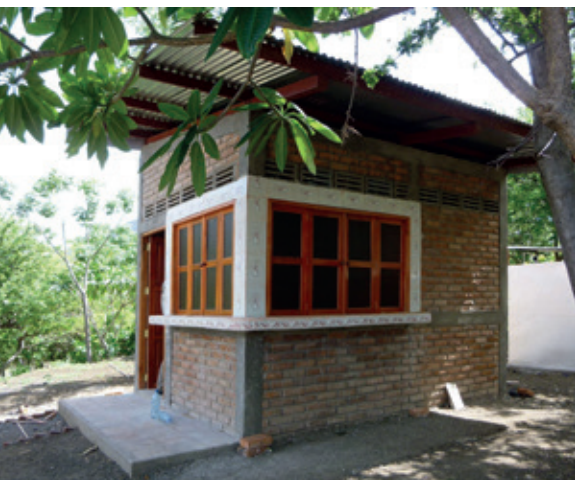
Die neu gebaute Küche für das Informationszentrum der Kooperative ‚Las Pilas – El Hoyo‘ am Cerro Negro
