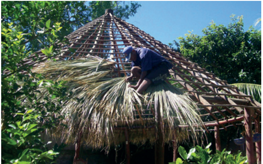
Das Dach des Ranchos wird erneuert
