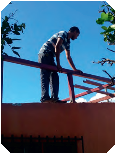
Las Tias... neues Dach
