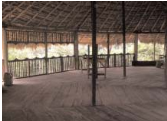
Hier fehlen noch die Trennwände für verschiedene Arbeitsräume, die gemütliche Atmosphäre ist schon vorhanden
