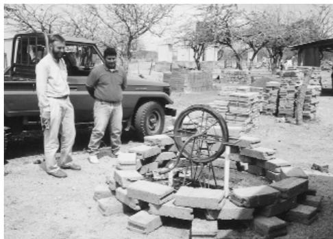
Bella Vista: Der runde Deckel mit Fördereinrichtung, der auf den noch offenen Schacht des verbesserten Notbrunnens aufgebracht werden muss
