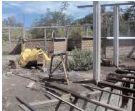
Fundament und Träger stehen bereits. Der Kühlraum für die Medikamente wurde unterirdisch gegossen.
