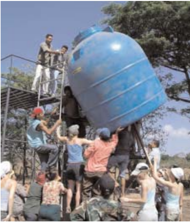
Der Wassertank wird installiert
