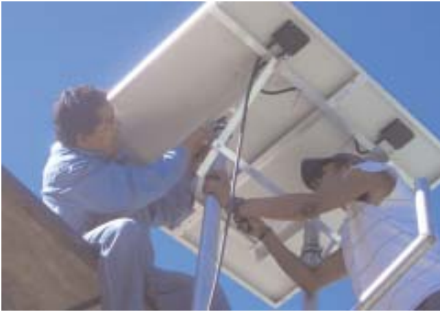
Installation einer Solaranlage
