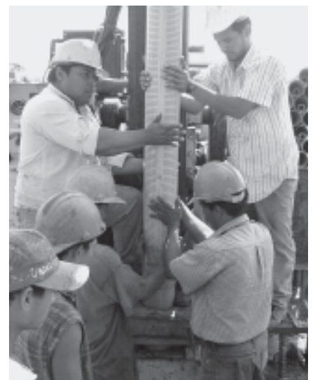
Im April 2001 konnte der neue Brunnen in Bella Vista gebohrt werden.
